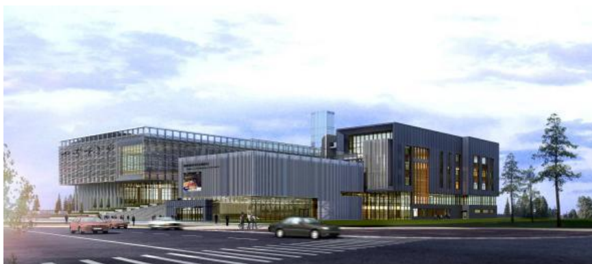
青岛开发区重点工程全民健身中心
